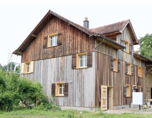
Altes wurde konsequent erhalten
